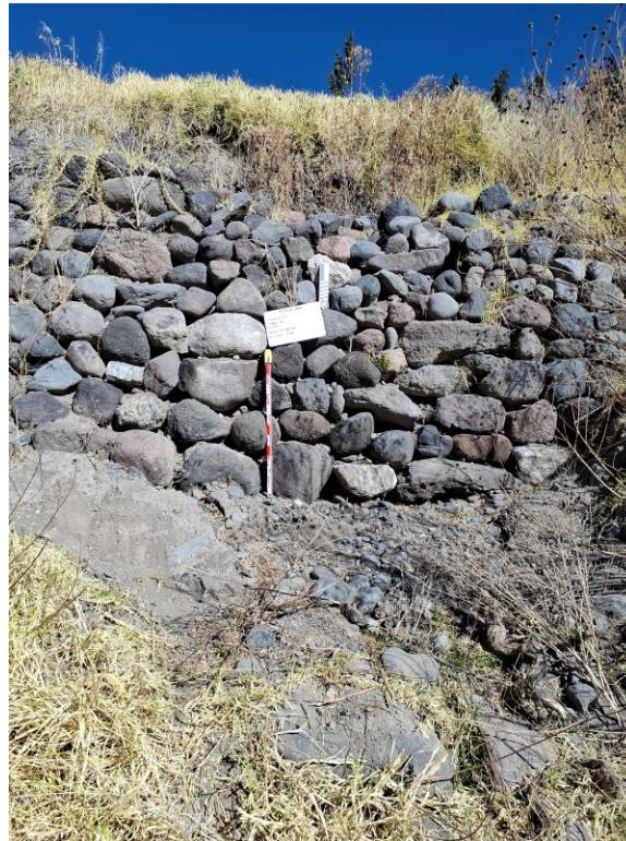
Fig. 16: Sector 4, Complejo 10, Chakra 8. Construcción con escombros al azar y mampostería de piedra sin trabajar.
