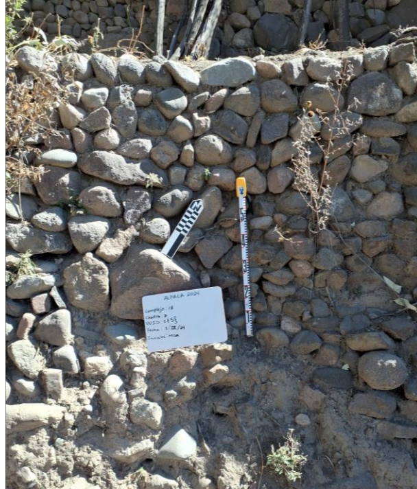
Fig. 30: Sector 8, Complejo 18, Chakra 2; terraza de banco en uso; escombros gruesos, mampostería de piedra sin trabajar.
