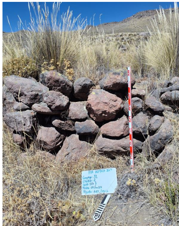
Figura 37: Sector 10, Complejo 32, Chakra 2; terraza de chakra en pendiente; abandonada; escombros gruesos, mampostería de piedra sin trabajar.
