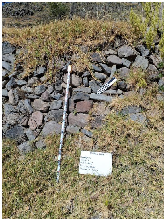
Fig. 23: Sector 6, Complejo 16, Chakra 4; terraza de banco; en barbecho; escombros al azar, mampostería de piedra sin trabajar.
