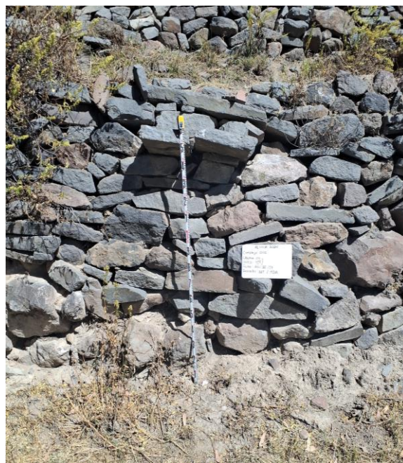
Fig. 3: Sector 1, Complejo 1, Chakra 5; terraza de banco en uso, con escombros al azar y mampostería de piedra partida.
