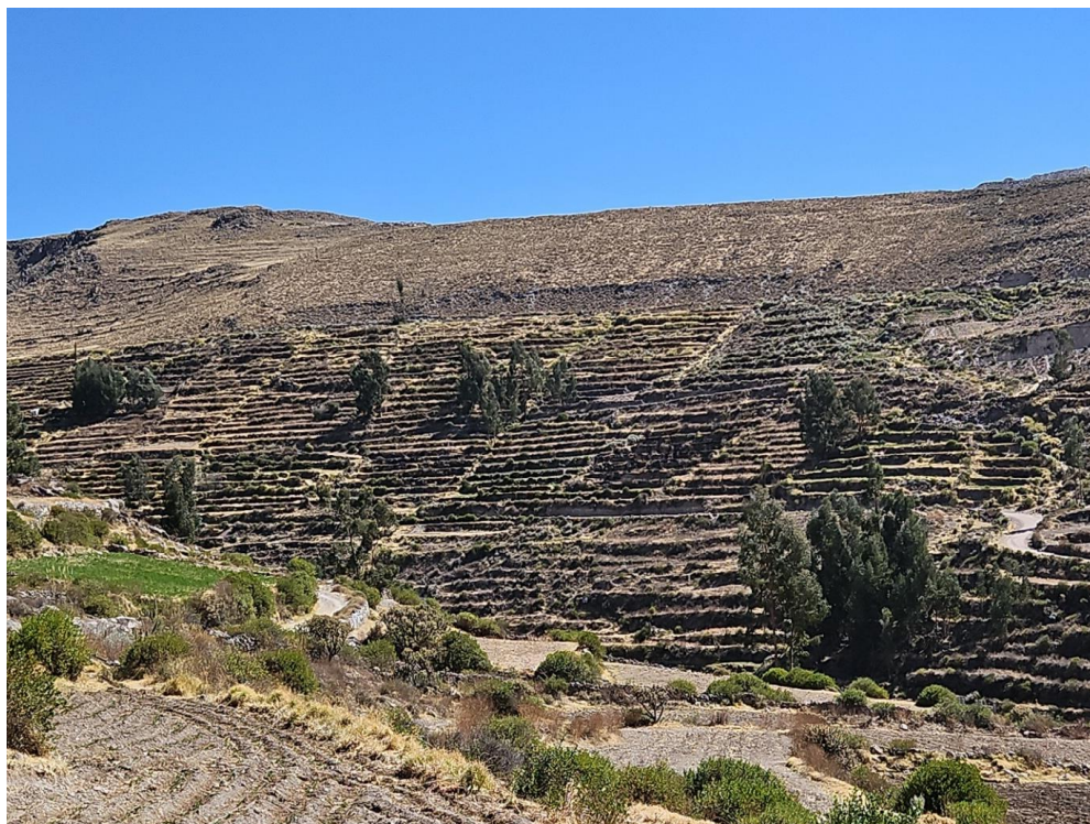
Fig. 5. Vista panorámica de los andenes de Sector 2.
