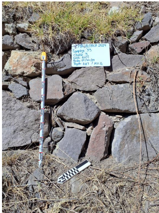
Figura 40: Sector 11, Complejo 33, Chakra 3; terraza de banco; abandonada; escombros gruesos, mampostería de piedra sin trabajar.
