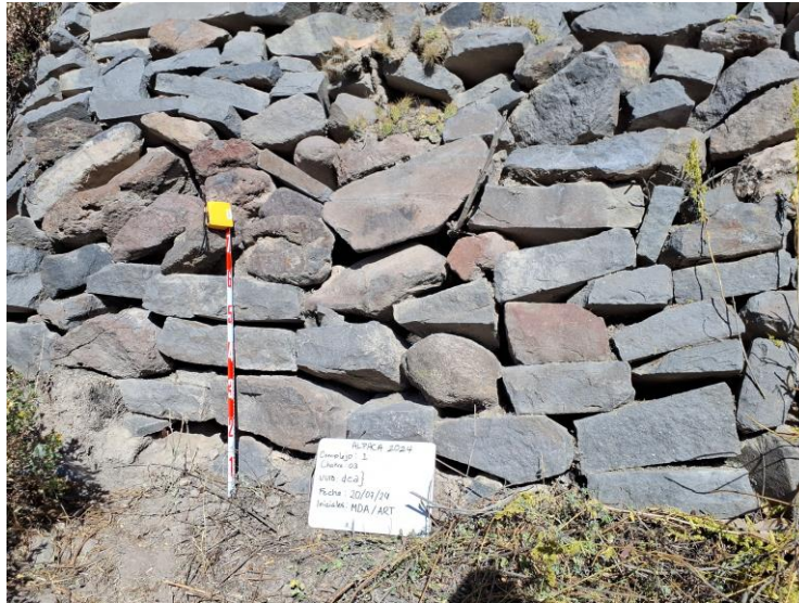
Fig. 2: Sector 1, Complejo 1, Chakra 3; terraza de banco en uso, con escombros al azar y mampostería de piedra partida.
